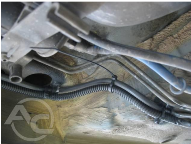
Рис. 1.3.21 Крепление электрических проводов с помощью зажимных хомутов
