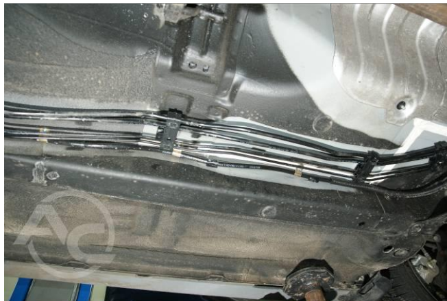
Рис. 1.3.24 Мозowanie за pomocą opasek metalowych
